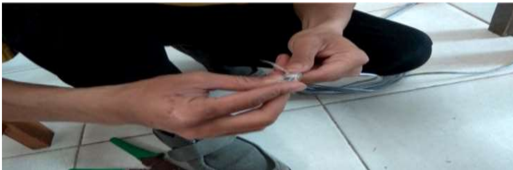
Gambar 5. Pemasangan Konektor RJ 45 pada Kabel UTP
