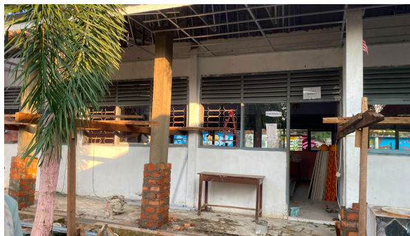
Gambar 2. Kondisi bangunan ruang kelas dan laboratorium IPA pada tahap rehabilitasi
