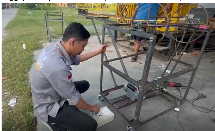
Gambar 3 Perakitan dan pengetesan Mesin penarik rumput laut berbasis PLC
