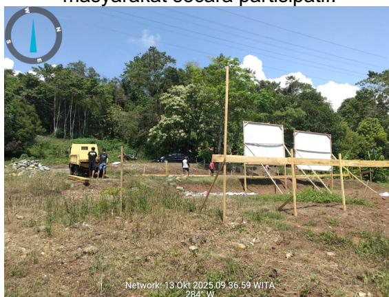
Gambar 5. Proses persiapan lahan dan pemasangan bowplank sebagai tindak lanjut implementatif dari hasil pendampingan perencanaan.
