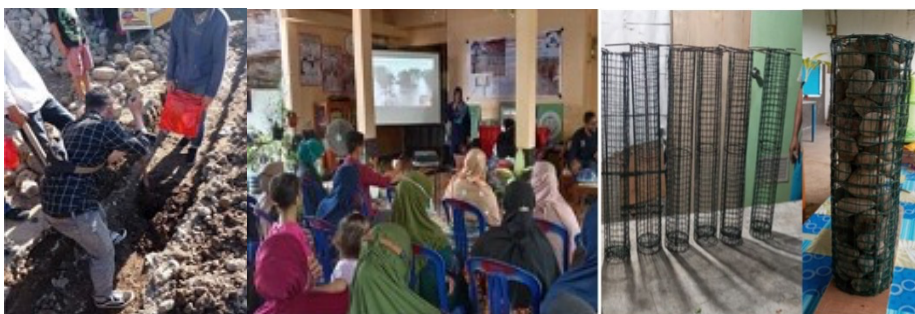
Gambar 4. Proses Instalasi Saluran Drainase Pori
