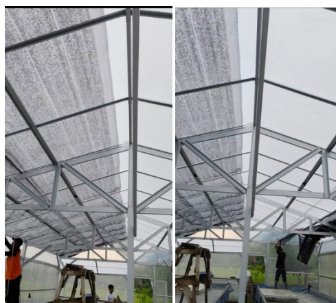
Gambar 2. Pemasangan Paranet
