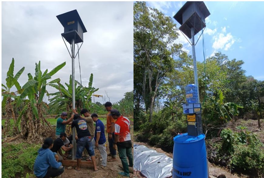
Gambar 7. Pemasangan Rubuha + pada lahan yang menjadi demoplot
